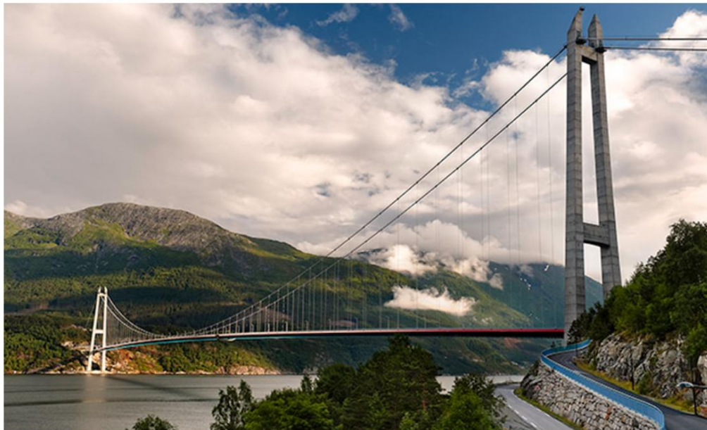
Hardangerbrua. Foto: Hordaland fylkeskommune.
